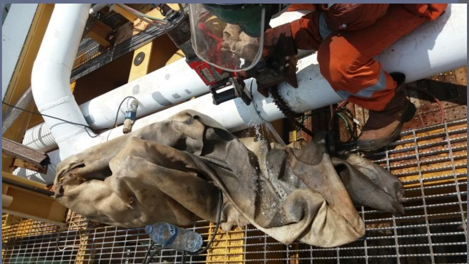
Pemotongan saluran pipa lama dengan cold cutter
